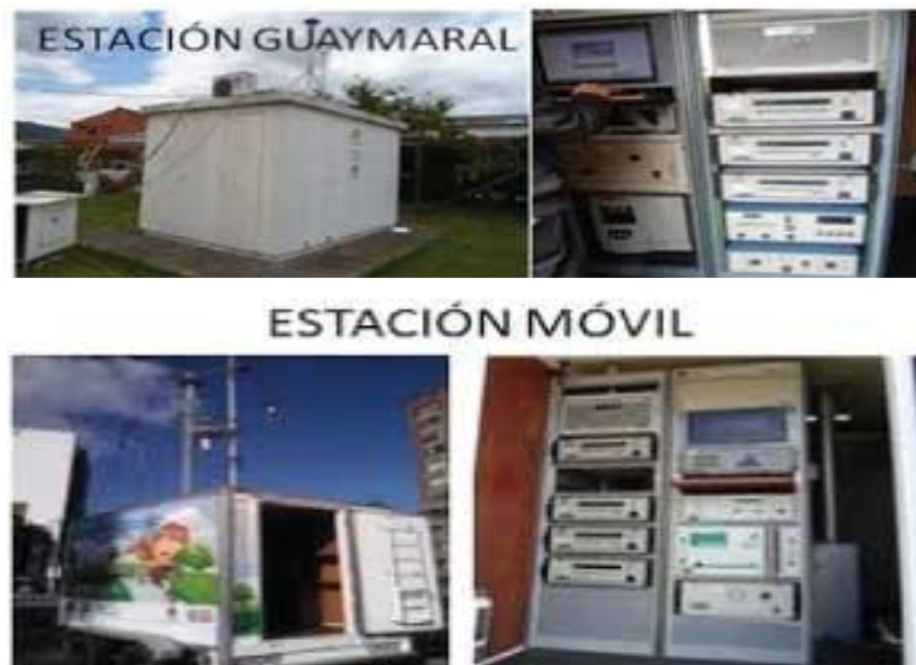
Fuente 15 Fotos de las estaciones de calidad del aire en Bogotá, IBOCA (2019)
