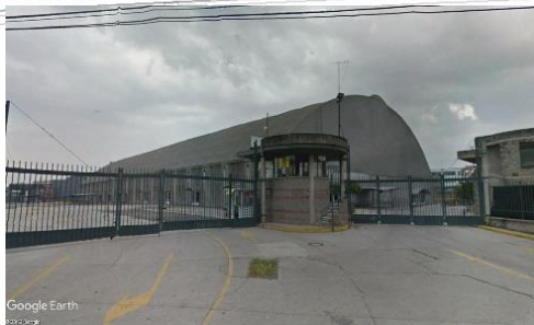
Imagen 8. Carpa de Corferias. Fuente: Google Maps
