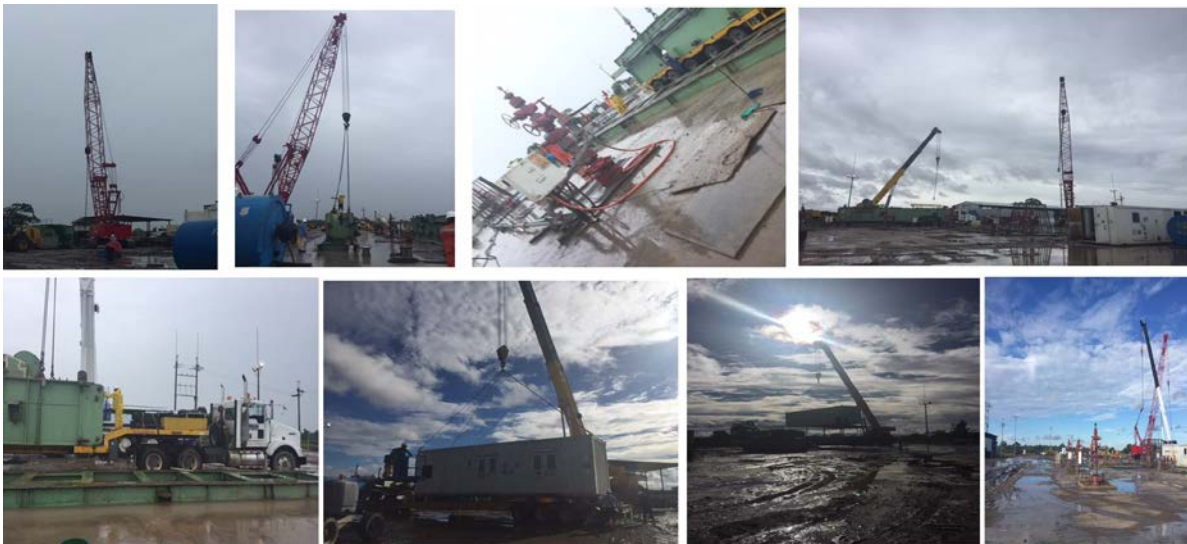
Ilustración 3. . Izaje de cargas. Procedimiento para el izaje de BOP y casetas de campamento dentro de la locación. Departamento de QHSES de Petrex Sucursal Colombia. Reporte diario HSE 10/04/2018. Reimpreso con permiso.
