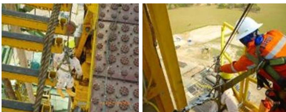
Ilustración 9. Simulacro de rescate en alturas usando el Sistema RollGliss desde el Trabajadero. Ejecución de procedimiento de emergencia para rescate en alturas. Departamento de QHSES de Petrex Sucursal Colombia. Reporte diario HSE 11/05/2018. Reimpreso con permiso.
