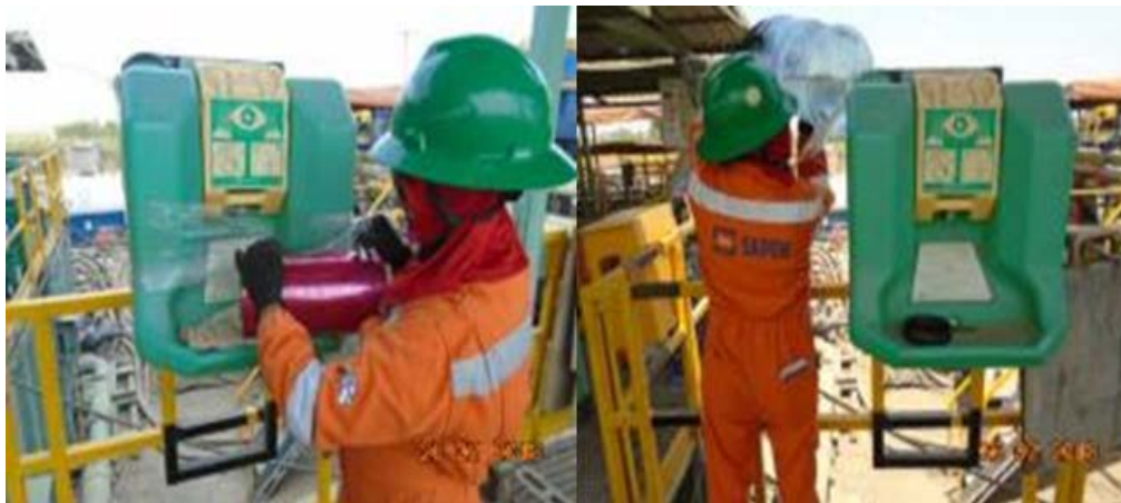
Ilustración 6. Limpieza de estaciones de lavado de ojos. Procedimiento de orden y aseo dentro de las instalaciones de la locación: sistema de lodos. Departamento de QHSES de Petrex Sucursal Colombia. Reporte diario HSE 28/04/2018. Reimpreso con permiso.
