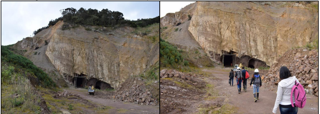
Fotografía 3.3. Tramo Final de la vía que conduce a la bocamina
