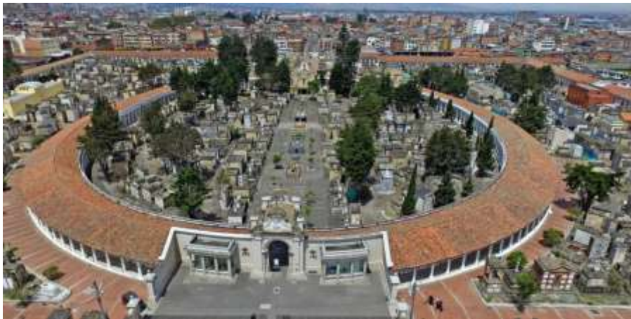
Imagen 15. Vista aérea cementerio central
