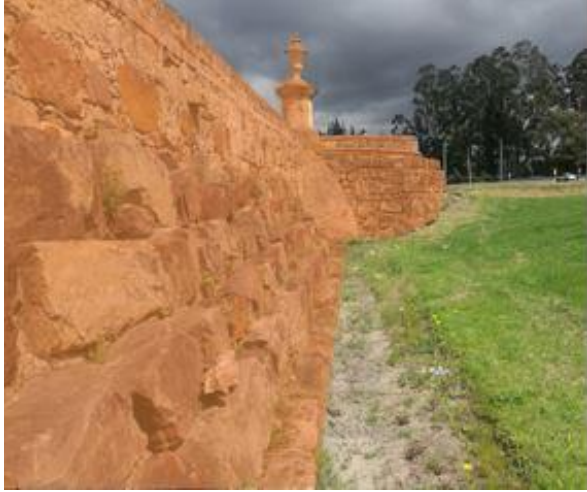
Ilustración 15. Puente del Común, Camellón.
