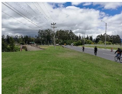
Ilustración 44. Costado oriental del puente.
