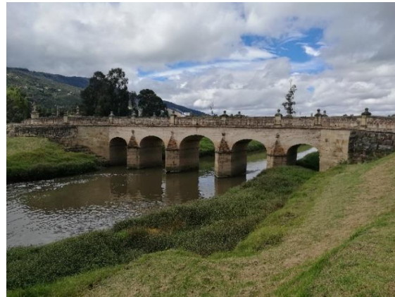
Ilustración 39 Camellón del puente
