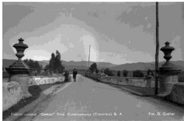
Ilustración 14. foto 1930 - Costado occidental.
