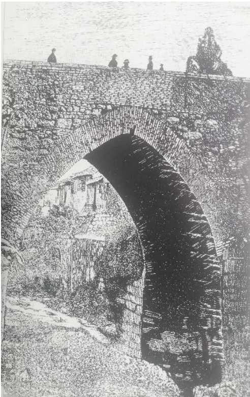
Ilustración 33. Puente de San Francisco.
