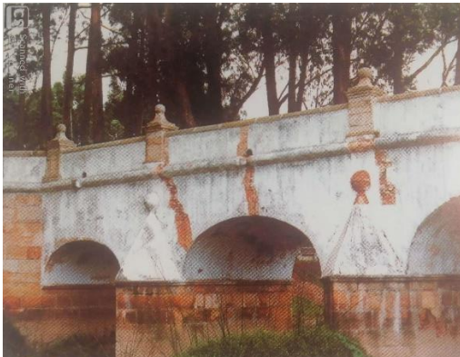
Ilustración 25. Foto, Puente del Común (1997).
