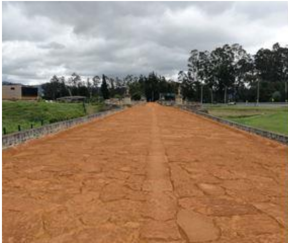
Ilustración 17. Puente del Común, Calzada Principal.
