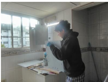
Fotografía 20. Construcción del prototipo
