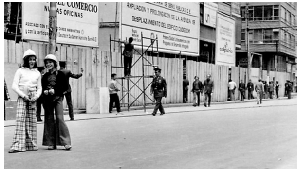
Figura 52-53. Preparativos para la puesta en marcha del desplazamiento del edificio CUDECOM. Transmisión televisiva. Imágenes tomadas de Traslado del Edificio CUDECOM Bogotá-Colombia En Informes de la construcción Vol. 28 No. 274 de Octubre de 1975.
