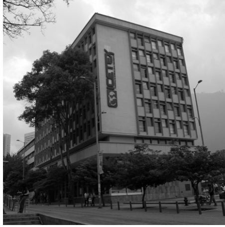
Figura 19. Edificio ICETEX 1964. Imagen tomada internet
