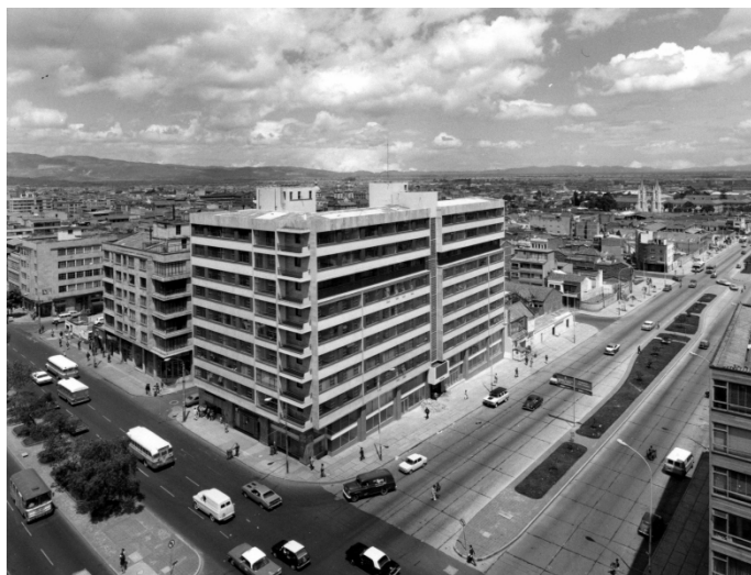
Figura 57. Edificio CUDECOM años después de su desplazamiento y con dos pisos adicionales. Imagen tomada del Fondo Paul Beer (s.c). Museo de Bogotá.
