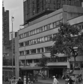
Figura 27. Edificio Alianza Francesa – Sede Centro (s.f). Imagen tomada de la Internet.
