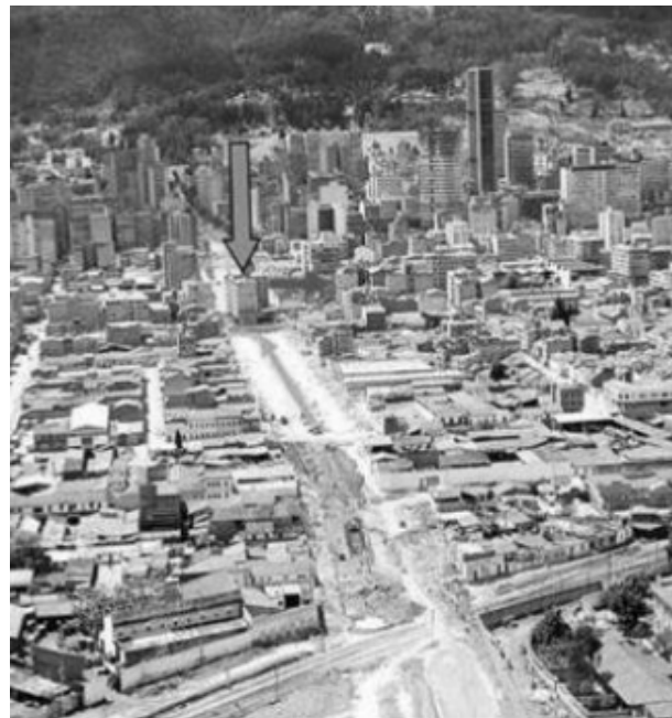
Figura 54. "Encuentro de dos vías". Imagen panorámica de la Calle 19 de Occidente a Oriente en el sector de San Façon. Tomada de Traslado del Edificio CUDECOM Bogotá-Colombia En Informes de la construcción Vol. 28 No. 274 de Octubre de 1975.
