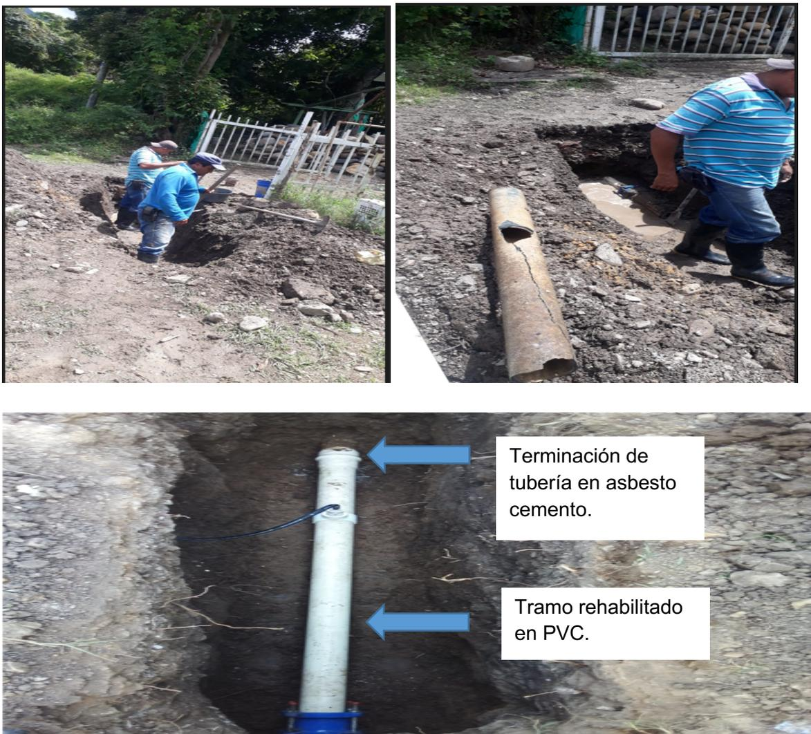
Figura 1. Daños presentados por tubería en asbesto cemento en la red de acueducto de EMPOAPULO S.A S.E.P.
