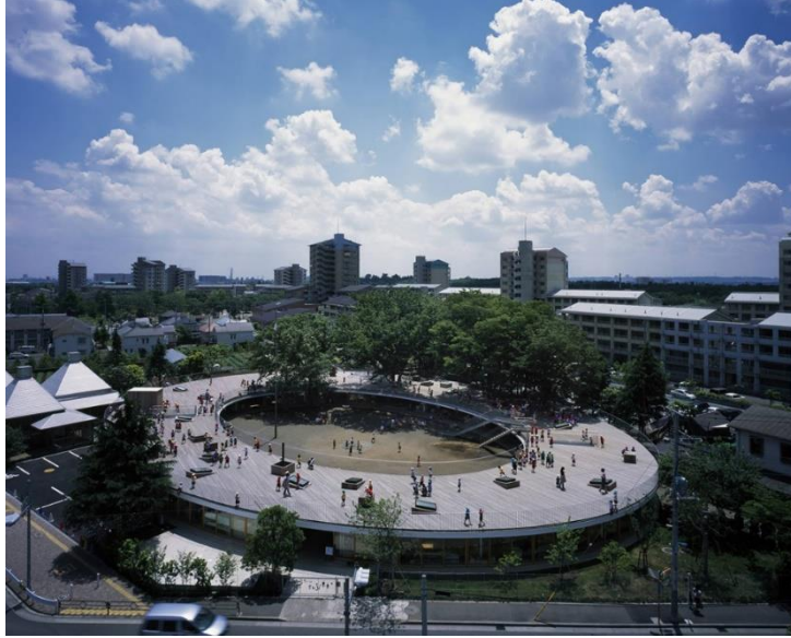
Imagen 9 Fuji Kindergarten exterior. Fuente: Página web de Tezuka Architects
