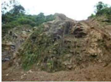
**Imagen 25.** Coluvio cerca del pie del talud con remanentes de vegetación.
