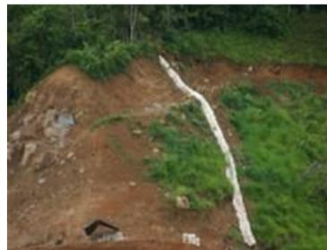
**Imagen 28.** Detalle de canaleta de recolección de agua y disipadora de fuerzas erosivas rodeando la corona y lados del talud.
