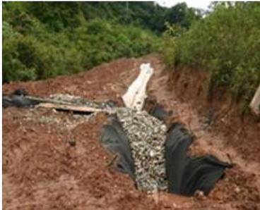
**Imagen 47.** Trinchera, tela asfáltica impermeable y gravilla.
