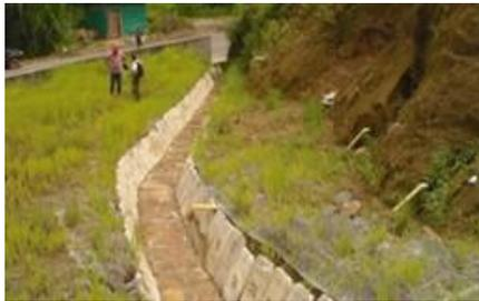
**Imagen 64.** Canal de desagüe y detalle del cárcavamiento en formación en el talud lateral que terminara afectándolo.
