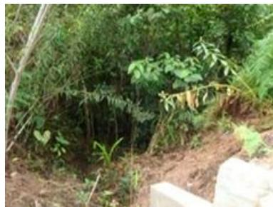
**Imagen 51.** Interrupción de la canaleta en concreto que termina en una quebrada.
