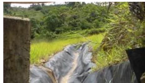
**Imagen 65.** Detalle de la Tela asfáltica recubre la canaleta y conduce el agua hacia la parte baja del talud.
