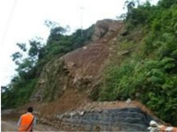
**Imagen 24.** Talud en borde de la vía con estructura de contención.
