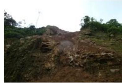
**Imagen 26.** Coluvios inestables en la parte baja del talud.
