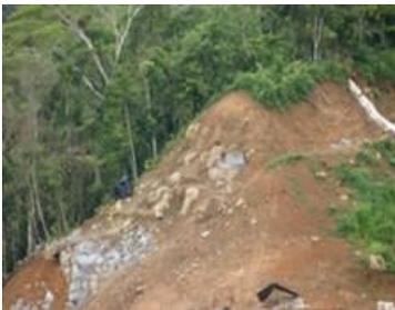
**Imagen 27.** Corona del talud con presencia notoria de coluvios inestables.
