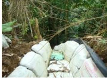
**Imagen 39.** Bolsas de concreto formando canal de escorrentia.
