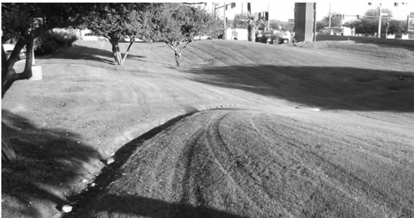
Freie Geländemodellierung mit einem Graben und einer Senke zur Wasserversickerung.
