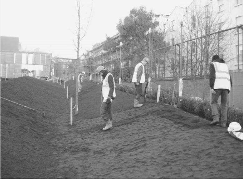
Manuelle Verdichtung des Oberbodens vor der Verlegung des Rollrasens.
