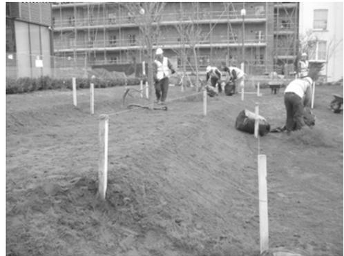
Erosionsschutz und Pflöcke mit Schnurprofilen.
