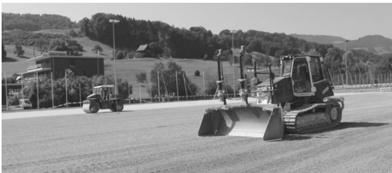
Kettendozer Cat D6K LGP «Rodian». Der Kettendozer beim Erstellen der Reinplanie für die Asphaltsschicht von einem Kunstrasensportplatz mittels GNSS-Steuerung.
