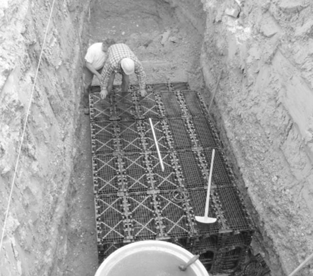
Ein mehrere Meter tief in die Erde eingebautes Rückhaltesystem. Allerdings wurden bei dem Projekt die Sicherheitsbestimmungen nicht eingehalten: Ein Abspunden der Wände ist Vorschrift.
