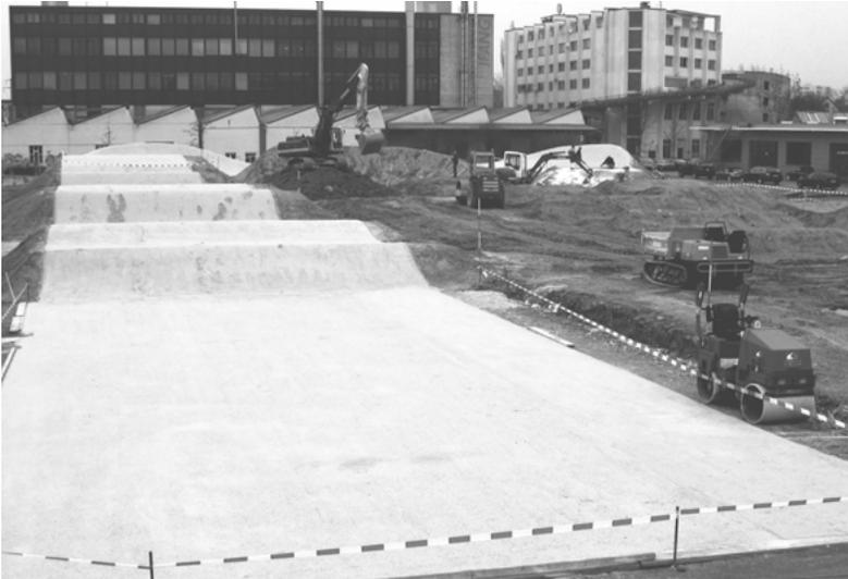
Der Fahrbahnbelag besteht aus Brechsand 0/3. Der Sand wurde, mit viel Wasser gemischt, wie ein Teig direkt eingebracht und nur mit Vibroplatten verdichtet.
