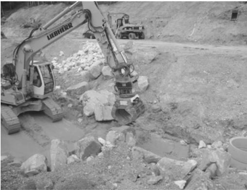
Die Arbeit mit dem eingemessenen und kalibrierten Sortiergreifer. Links oben: Stein aufnehmen. Rechts oben: Stein lagerecht versetzen. Links: Höhe prüfen und korrigieren.
