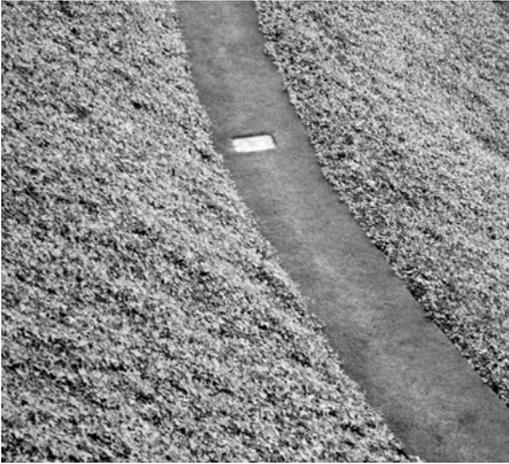
Böschungssicherung mit Efeu,
