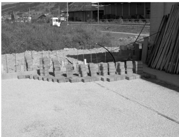
Die Produzenten empfehlen die Einhaltung eines Mindestgefälles von drei Prozent auch für wasserdurchlässige Betonpflastersysteme. Alle darunter liegenden Schichten (Bettungsschicht, Tragschicht etc.) müssen das Gefälle der Oberfläche aufweisen.
