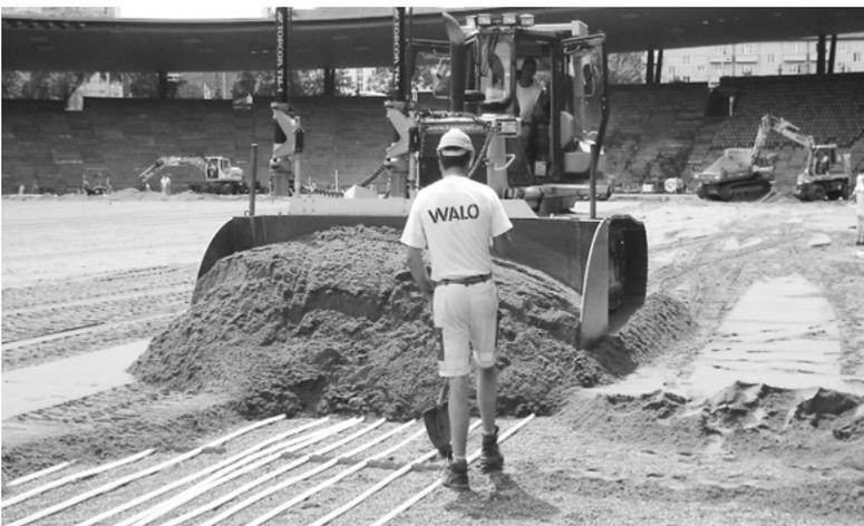
Ein Bulldozer mit 3D-Maschinensteuerung übernahm den Einbau der Sand- und Rasentragschicht.
