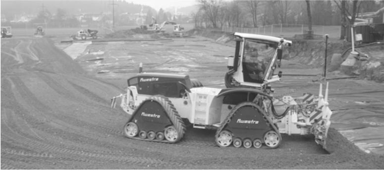
Trakdozer® Claas Xerion 3800 «Nöldi» mit Zulassung für Straßenverkehr und GPS-gesteuerter Grabenfräse. Der Trakdozer® beim Einbau von stabilisierter Fundationsschicht und Planierarbeiten auf einem Sportplatz mittels GNSS-Steuerung 3DMC2 von Topcon.
