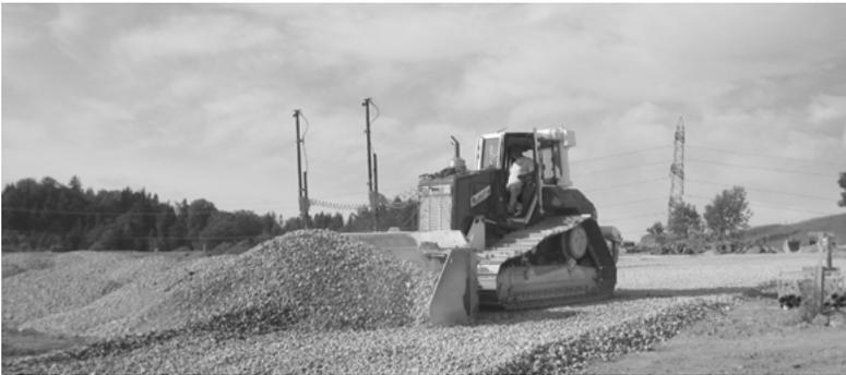
Kettendozer Cat D6N LGP «Obelix». Der Kettendozer beim Einbringen und Planieren einer Filterschicht für die Rekultivierung einer Aushubdeponie mittels 3D LPS-Steuerung mit Totalstation.
