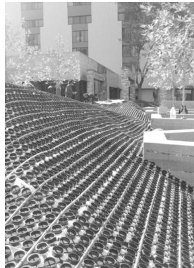
Slopetame2 Erosionsmatten nach dem Einbau.
