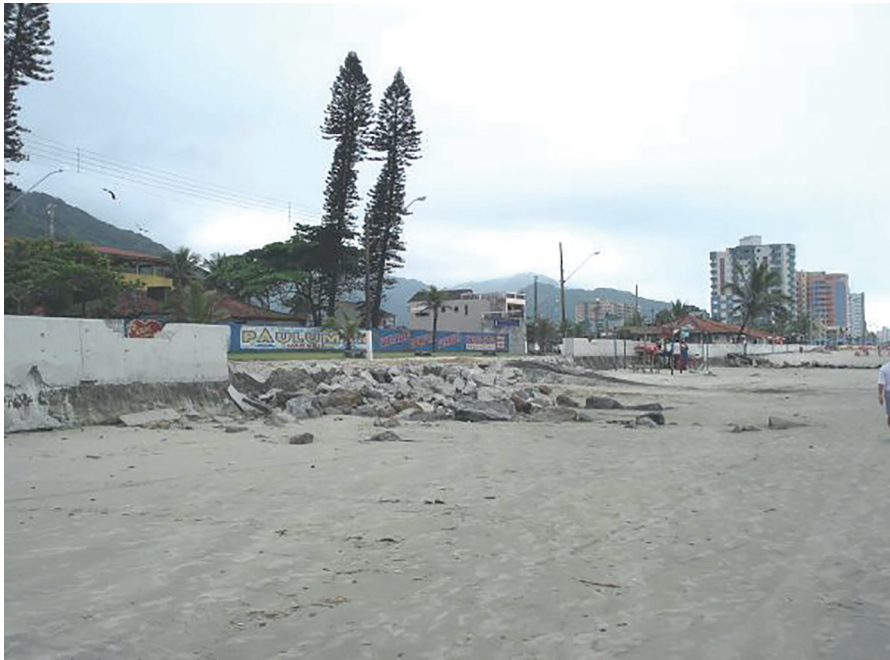
Figura 9.5. Processo da construção do calçadão à beira-mar sobre área de praia
