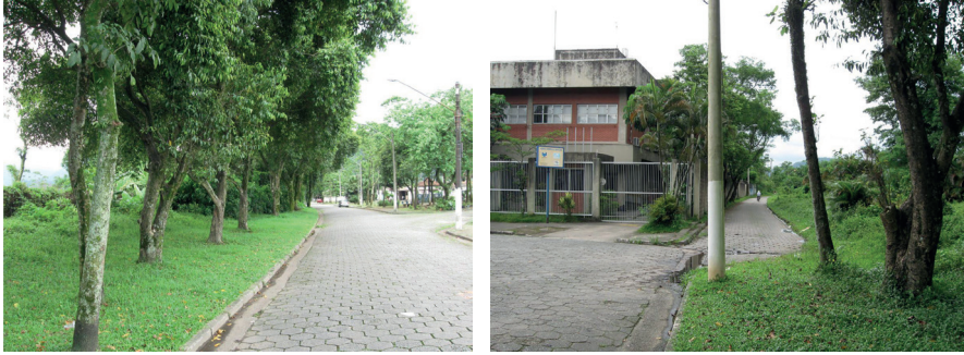
Figuras 6.8 e 6.9. Estruturas do uso urbano em trecho da unidade Planícies Fluviais Urbanizadas
