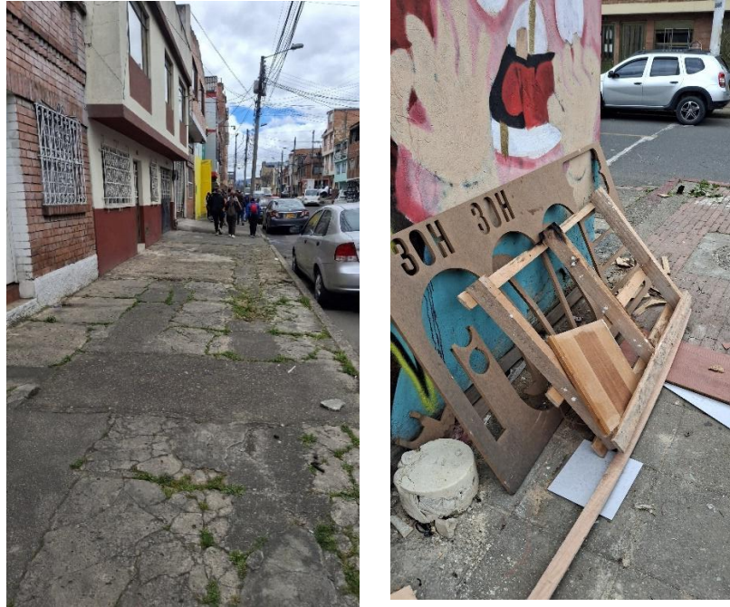
Figura 4: Condición actual de algunos andenes del barrio.
