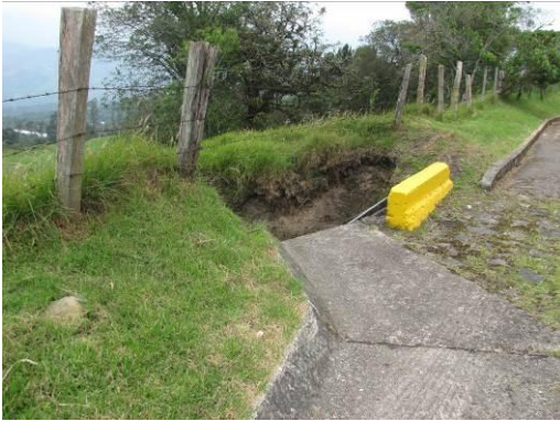
Fotografía 3.3. Cunetas y Alcantarillas Fuente: Grupo de Trabajo, 2013
