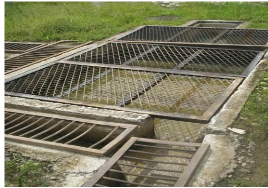
Ilustraciones 3.4 y 3.5. Ejemplo de Instalaciones de apoyo: cunetas perimetrales y cajas de Manejo de aguas lluvias y grises (Fuente: Google).
