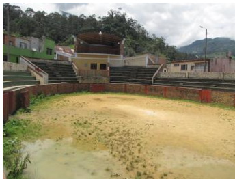
Fotografía 4-17 Plaza de Eventos
