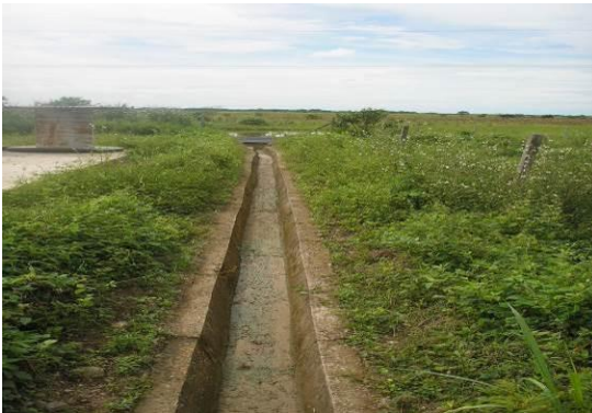
Ilustraciones 3.4 y 3.5. Ejemplo de Instalaciones de apoyo: cunetas perimetrales y cajas de Manejo de aguas lluvias y grises (Fuente: Google).
