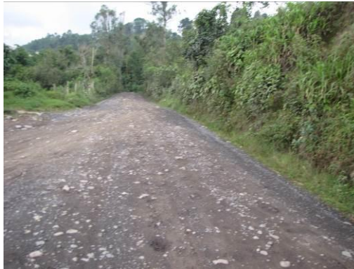
Fotografía 3.8. Vía de Acceso predio el Tambo
