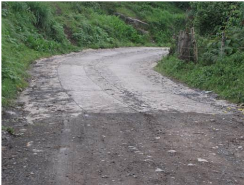
Fotografía 3.5. Vía de Acceso Fuente: Grupo de Trabajo, 2013
