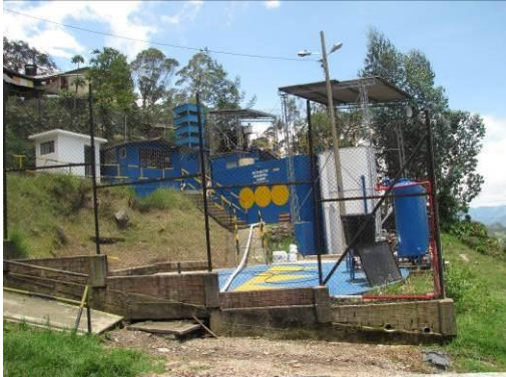
Fotografía 3.11. Acueducto Municipal de Albán Fuente: Grupo de Trabajo, 2013
