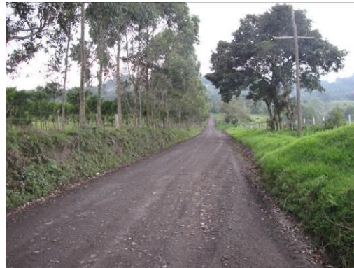
Fotografía 3.6. Vía de Acceso Fuente: Grupo de Trabajo, 2013
