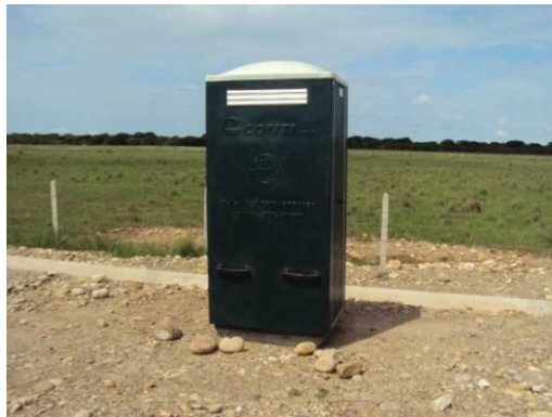
Ilustración 3.7. Manejo de residuos líquidos, servicio sanitario etapa constructiva
