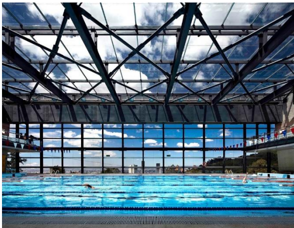
Ilustración 6 Estructura metálica https://www.arquitecturapanamericana.com/centro-deportivo-universidad-de-los-andes/nggallery/page/2
