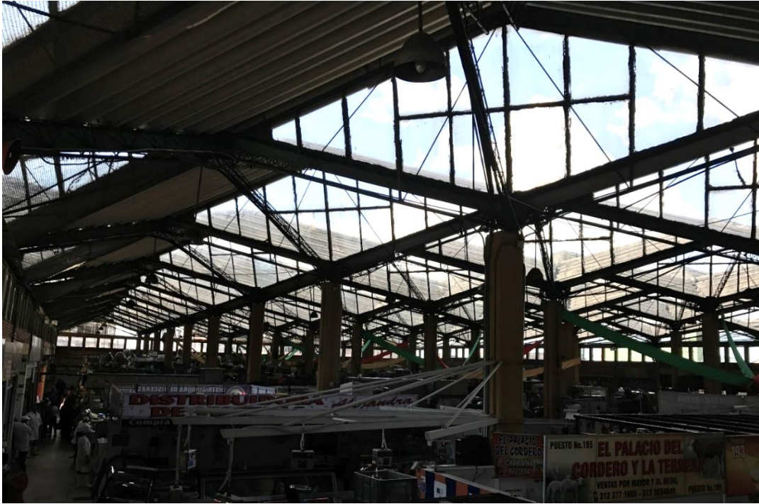
Imagen 38: Foto cubierta plaza de mercado 20 de julio
