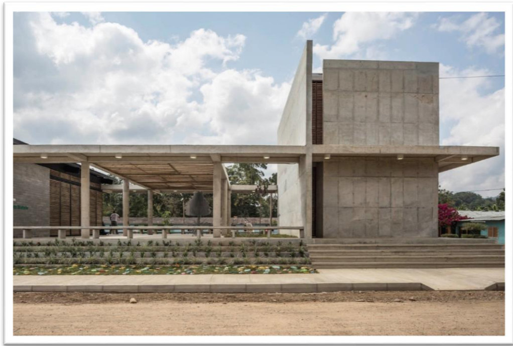
Ilustración 32: Fachada posterior de la casa de la memoria. ArchiDaily.
