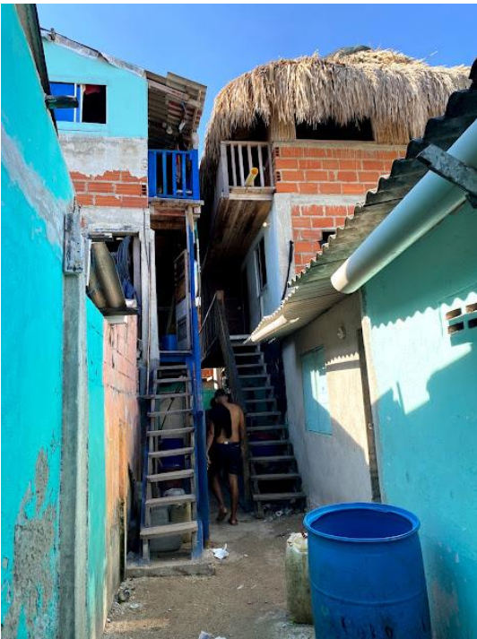
Imagen 52. Construcción de forma desordenada
