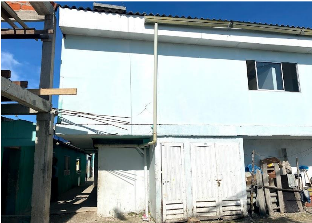
Imagen 47. Tanque de almacenamiento de agua y puesto de salud
