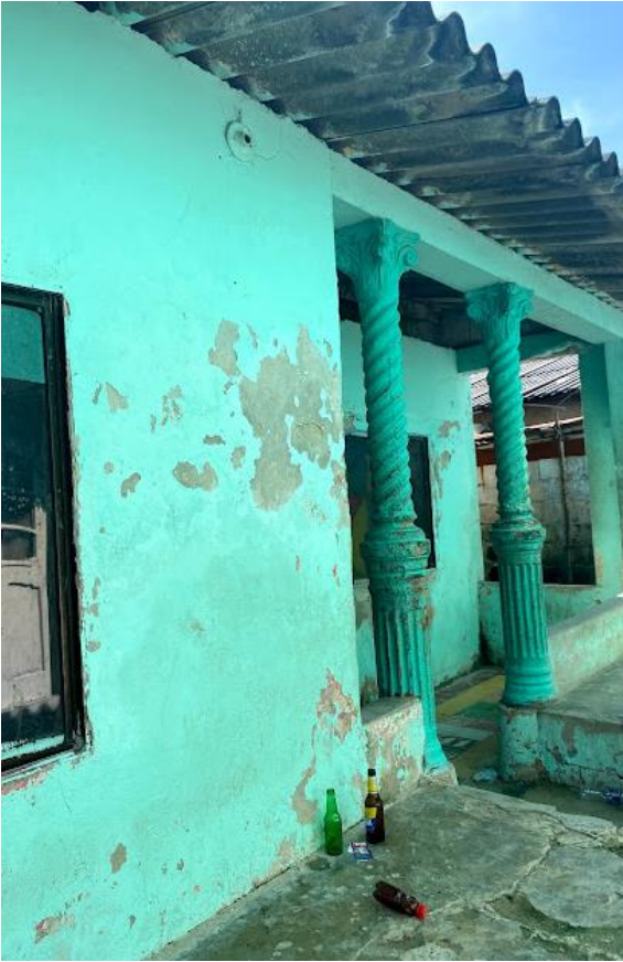
Imagen 41. Estado de viviendas de un piso
