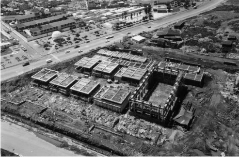
Ilustración 9 fotografía aérea centro de invidentes y débiles visuales. Fuente: Archdaily
