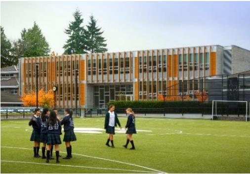
Ilustración 14 vista exterior, escuela york house. Fuente: Archdaily
