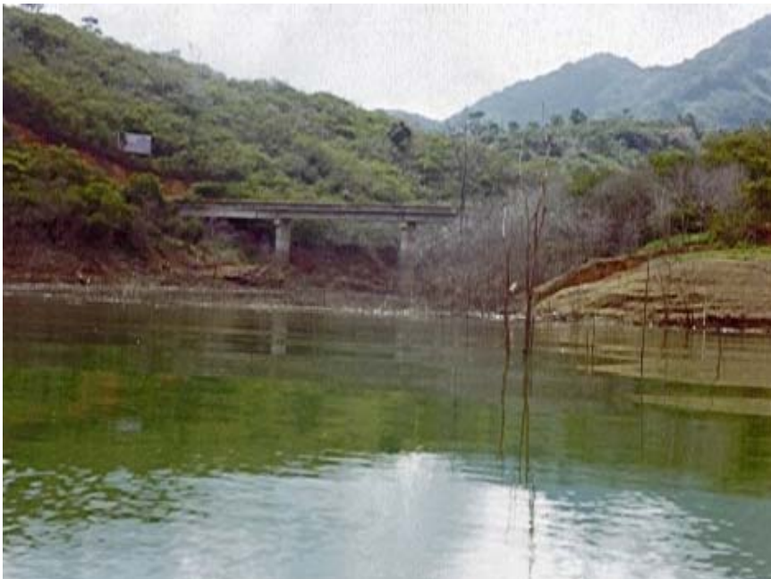
Figura 9. Estación Puente Fosforito
