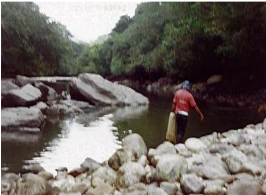
Figura 7. Estación Casa de Máquinas
