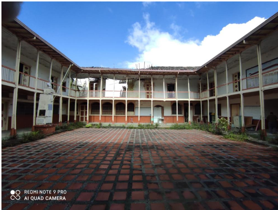
Ilustración 35 Estado Actual Crujía Oeste vista interna. Fuente Propia.
