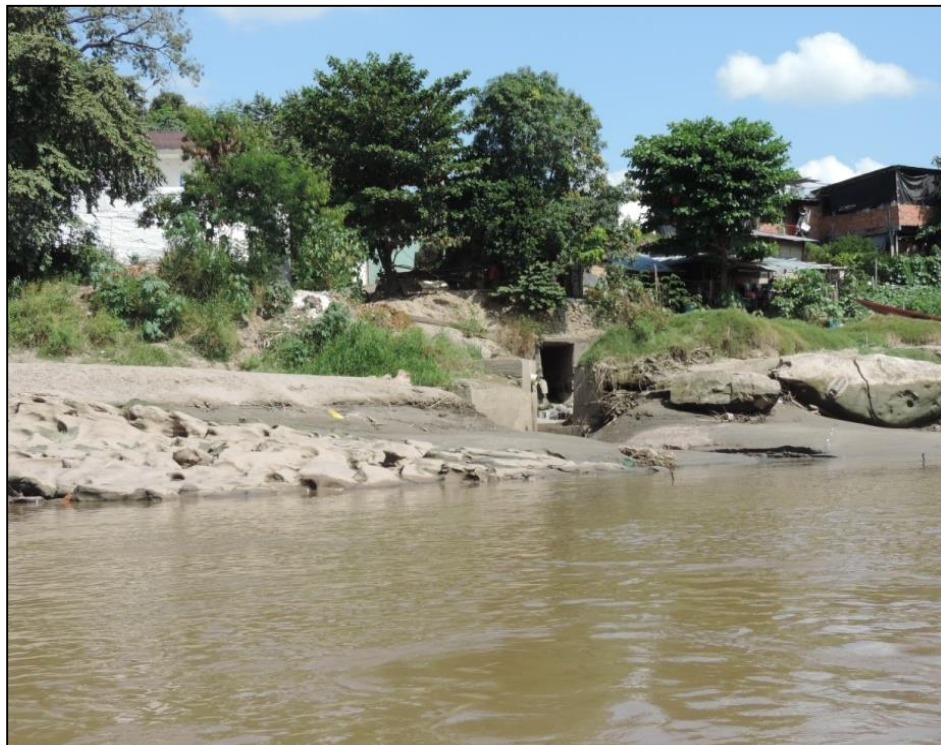
Figura 24. Vertimientos de aguas negras al río Magdalena, barrio Puerto Montero Girardot.
