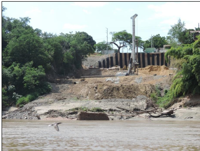
Figura 26. Construcción de un muro de contención sobre río Magdalena, barrio La Capilla Flandes. Fuente: Elaboración propia.
