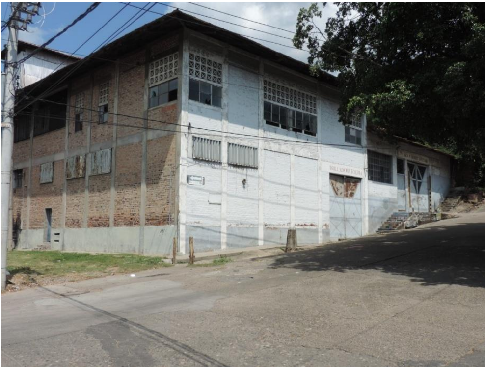
Figura 35. Electrificadora SKN. Fuente: Elaboración propia.
