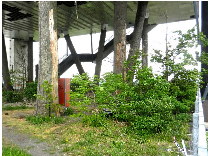
Figura 15. Pabellón – Elementos Estructurales
