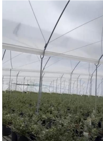
Imagen 6. Estructura de invernadero en acero para la producción de arándanos en la agro empresa Los Arrayanes
