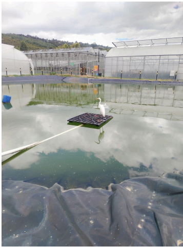
Figura 8. Reservorio de agua Fuente: Elaboración propia, 2024
