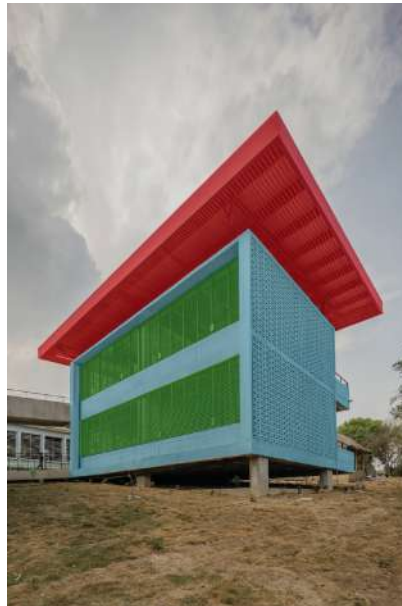
Figura 17. Ubicación de los diferentes sistemas constructivos (alero, celosía y persiana) en las respectivas fachadas de los módulos. Escuela Rural del Hobo.
