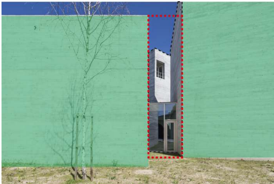
Figura 9. La dilatación como fragmentación del volumen y ruptura del plano de fachada. Centro de Interpretación del Románico.
