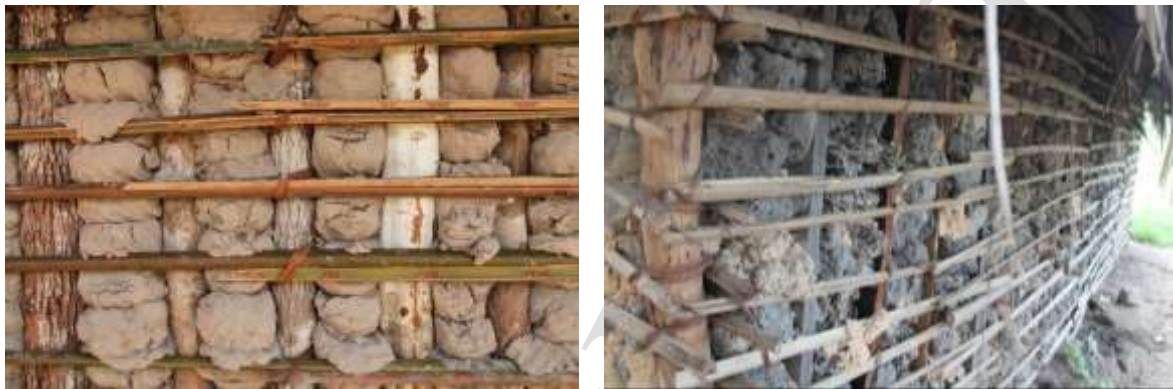
Figura 8. Fotos de detalles de distintos materiales usados al realizar la técnica quincha en aldeas Kayapó visitadas
