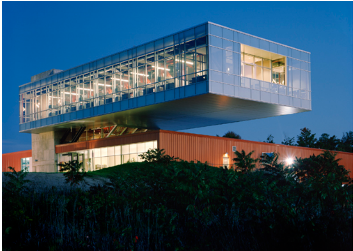
Imagen 15. Fotografía exterior Constructora Lamar
