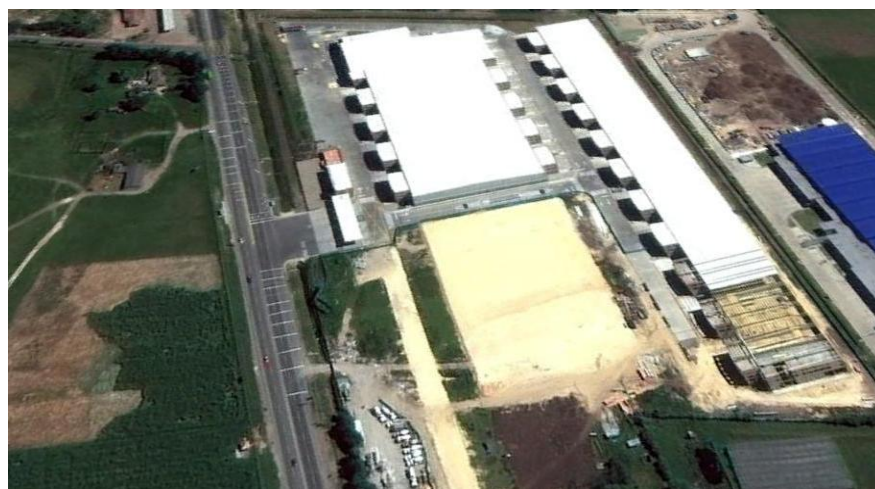
Figura: 6 Vista aérea parcial de la zona industrial ubicada sobre la Carretera central de Occidente. Fuente: Google Earth, 2010.
