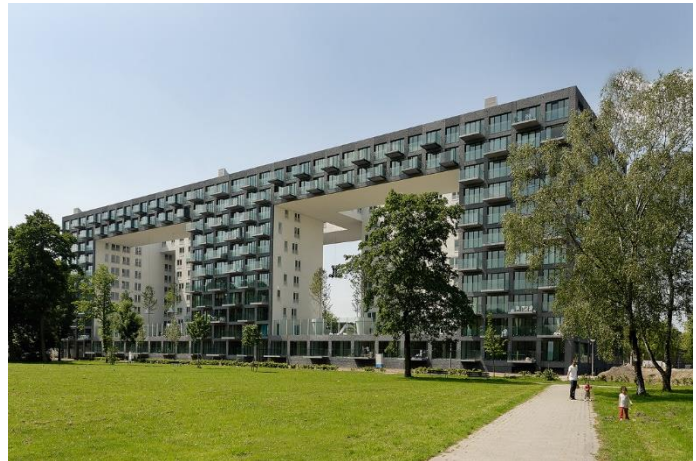
Fotografía 5: Vista edificio Parkrand MVRDV Fuente: MVRDV projects
