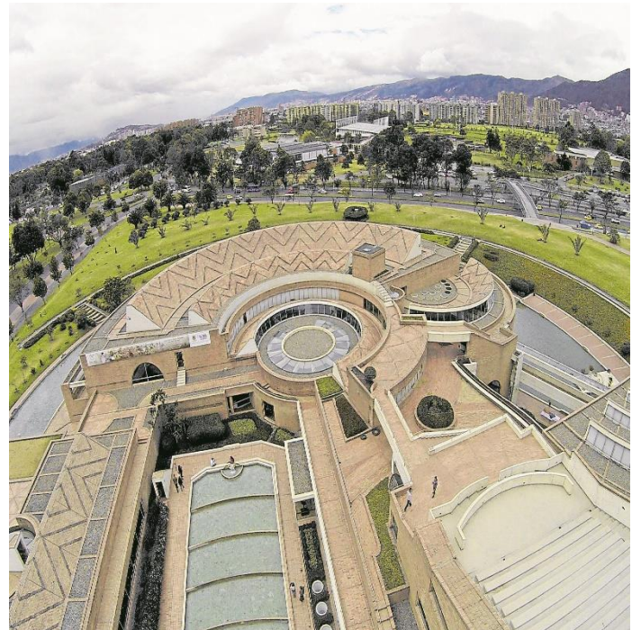
Fotografía 3: Cubierta B. Virgilio Barco Fuente: Bibliored
