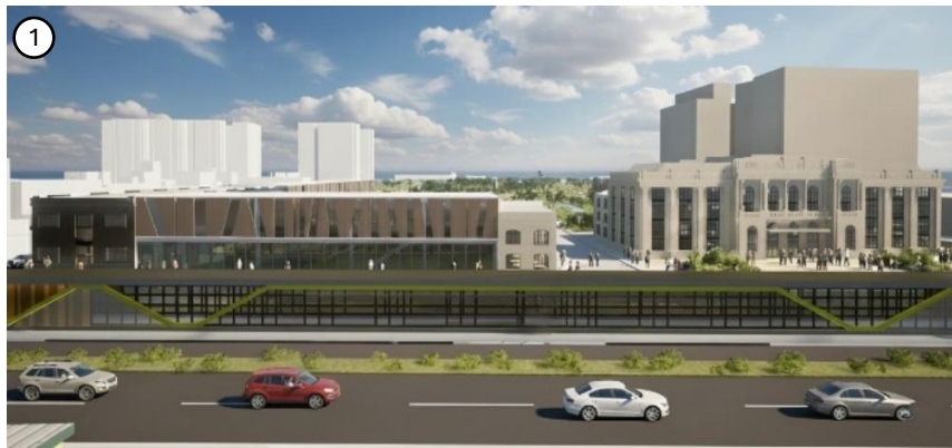
Ilustración 55. Estación Parque la Sabana. Elaboración propia.
