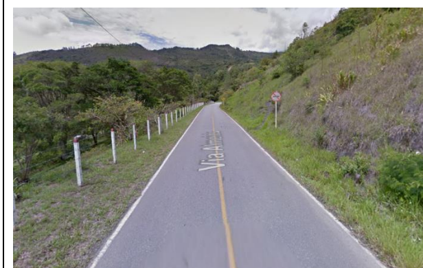
Foto 2.3. Vía Las Juntas – Almeida
