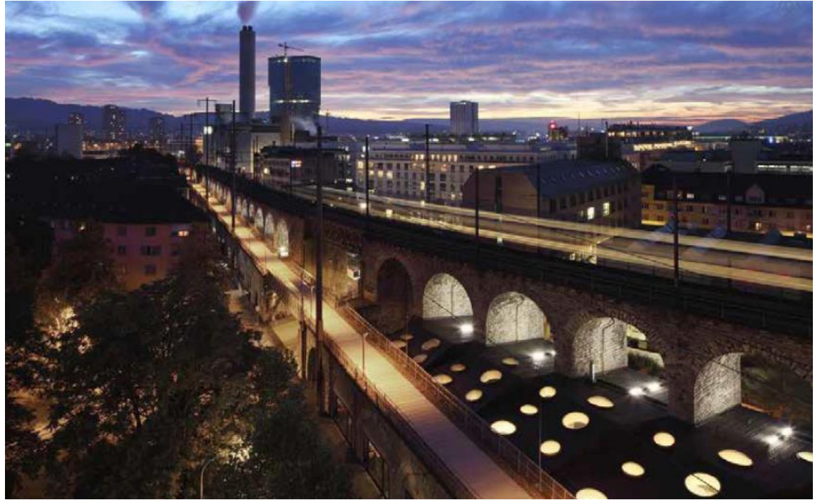
Ilustración 9: Viaducto reformado, afashiaarczine.com, 2015
