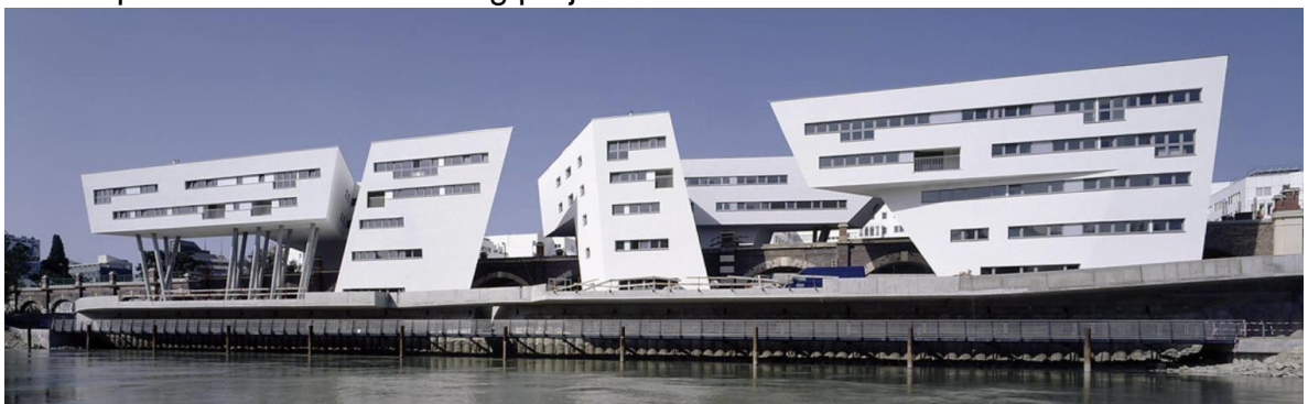
Imagen 1 Fotografía Spittelau Viaducts Housing Projects
