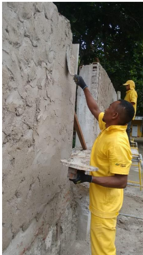
Ilustración 9. Aprendiz Escuela Taller - Albañilería pañetador
