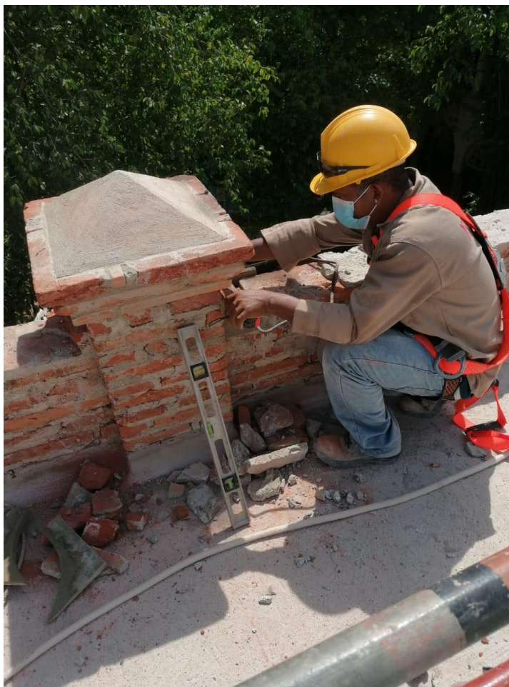
Ilustración 8 Construcción en ladrillo militar de Ático - Albañil y sus herramientas
