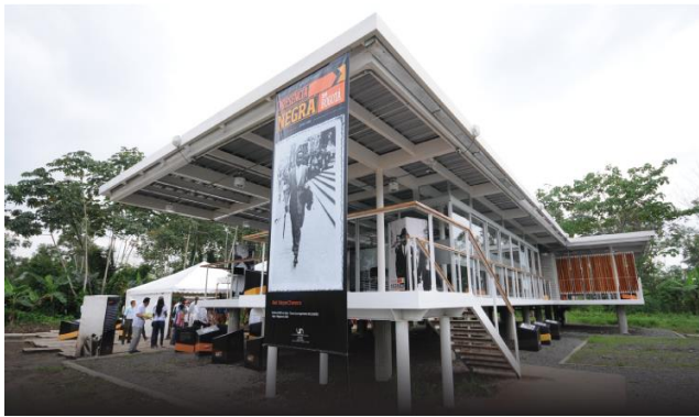
Figura N°12 UN Sede Tumaco. Pacífico UNAL (2018)
