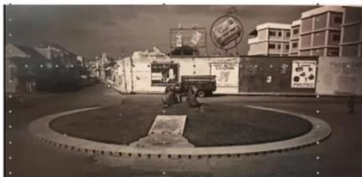
Ilustración 41 Fotografía año 1957, vista lateral del edificio
