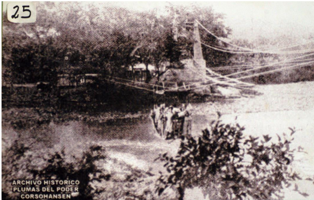
Imagen 8. Puente de los Suspiros (obsérvese el detalle de la columna en construcción del costado sur). Cruce del río Bogotá por medio de una Tarabita. Autor: anónimo. Fechas: aprox. 1880. Fuente: Archivo Histórico- Plumas de Poder. Museo Corsohansen.
