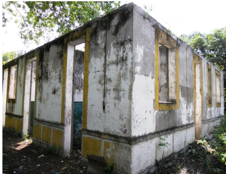
Imagen 25. Pabellón de la Desinfección, esquina suroriental o posterior. Fecha: 2011.
