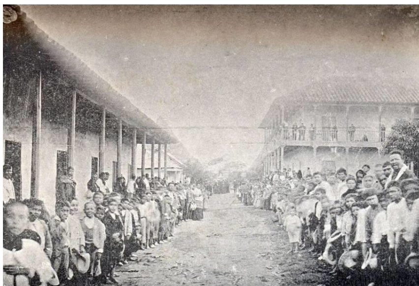
Imagen 7. Palacio Municipal - esquina derecha, estructura de dos pisos.
