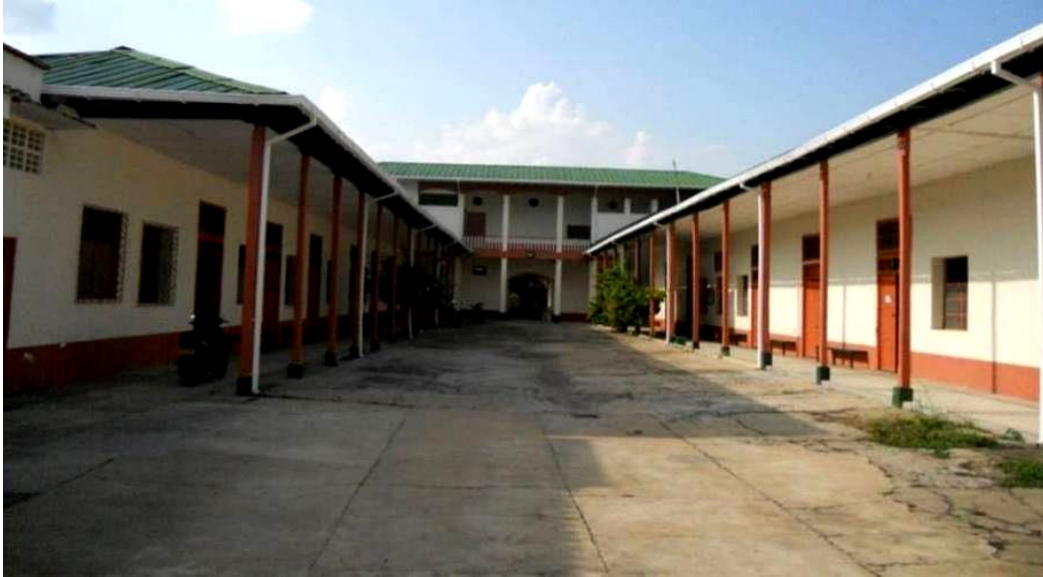
Imagen 29. Edificio Carrasquilla. Vista de la fachada principal sobre la carrera 9ª. Foto: Javier Bejarano. Fecha: septiembre 2011.
