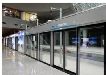
PUERTAS DE SEGURIDAD
