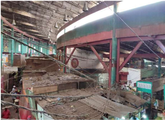
Imagen 14: Foto cobertizo de la plaza de mercado de Bazaruto
