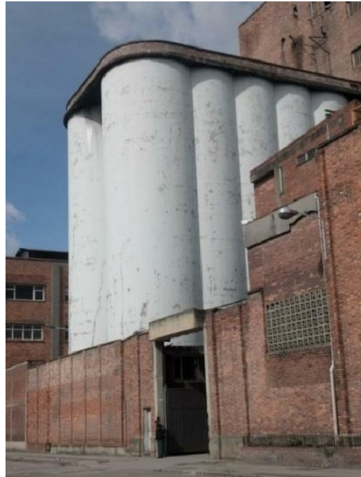
Figura 43. Silos en concreto. Fuente: Documento Técnico de Soporte del Plan Parcial Triángulo de Bavaria
