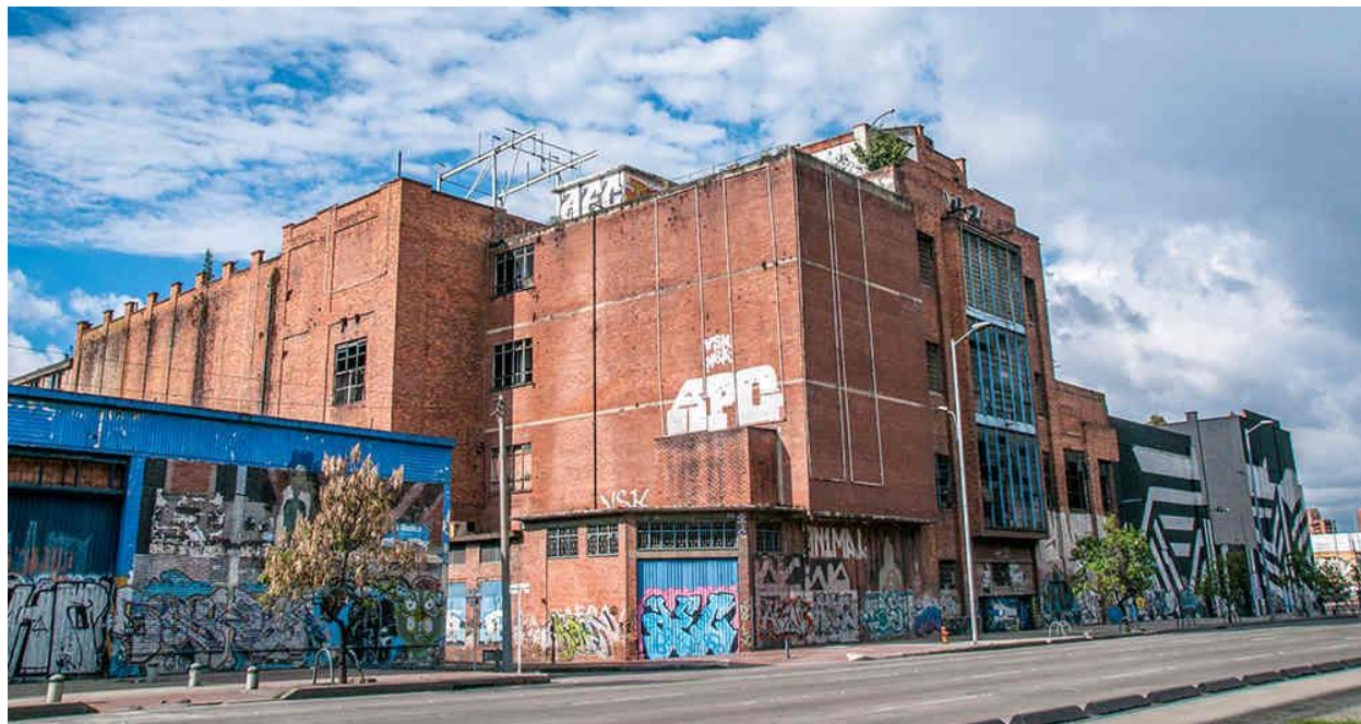
Figura 3. Abandono y deterioro de la Cervecería Andina. Fuente: Revista Semana.
