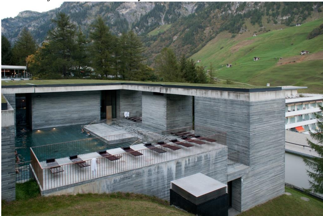
Figura 61. Vista aérea de las Termas de Vals. Fuente: ArchDaily
