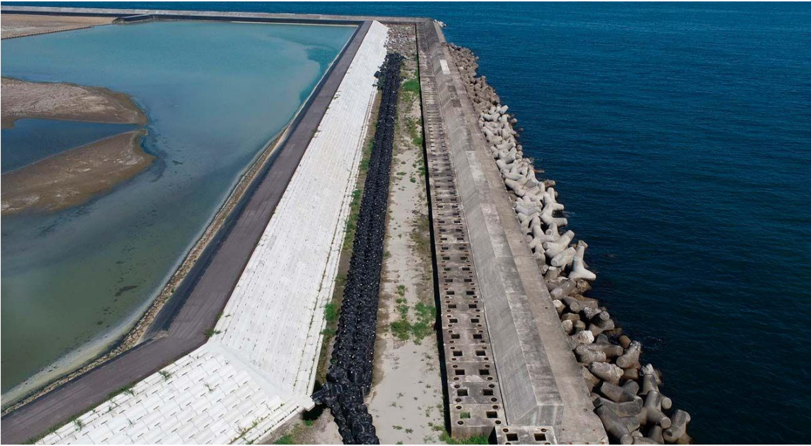
Figura 19 Dique antisunamis en la prefectura de Fukushima
