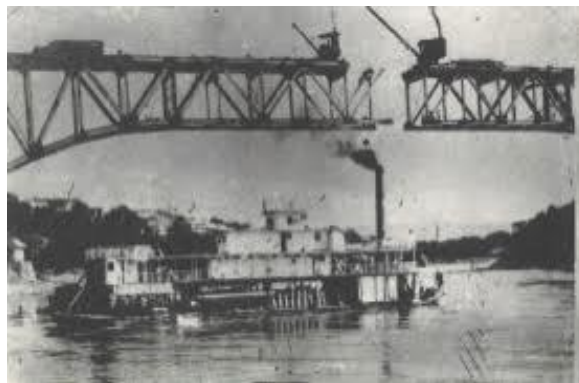
Figura 2. Puente férreo sobre Girardot
