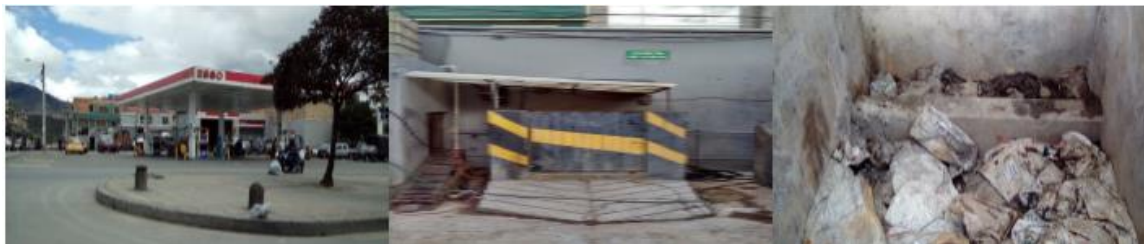
Figura 2 Foto estación de servicio ubicación del cuarto de lodos. Fuente: autores
