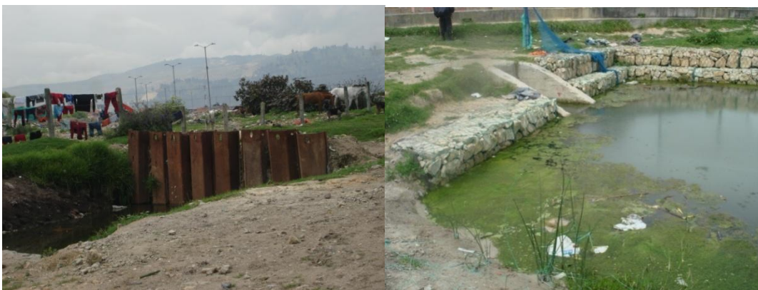
Foto 6. Obras de entrada de agua de la Quebrada Tibanica al Humedal costado suroriental (Izquierda) – Foto 7. Aguas lluvias costado oriental (derecha) con su respectivo sedimentador controlador de partículas en suspensión. Tomada mayo de 2011
