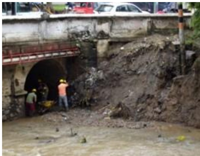
Figura 45. Evidencias Contaminación fuente hídrica río Molino.
