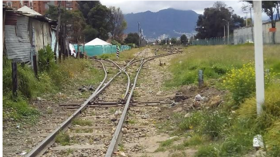
Figura 9. AV. Ferrocarril de Occidente
