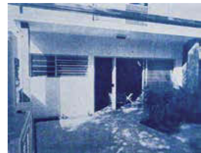
Casa à Rua Alagoas, de Kurt Hollander. Fachada posterior.
