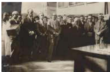
Lançamento da pedra fundamental do prédio da FAU-Mackenzie, em maio de 1960.
