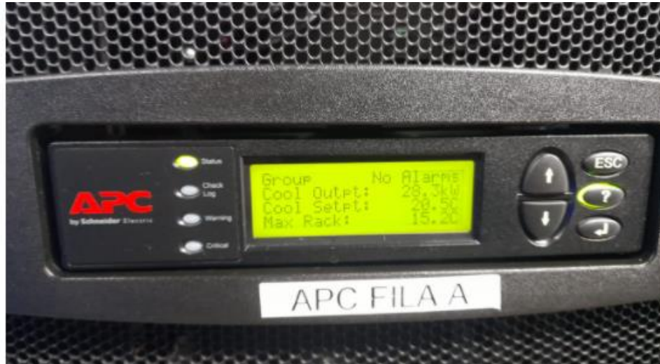
Imagen 9. Rack en el cual se encuentran sistemas POS.
